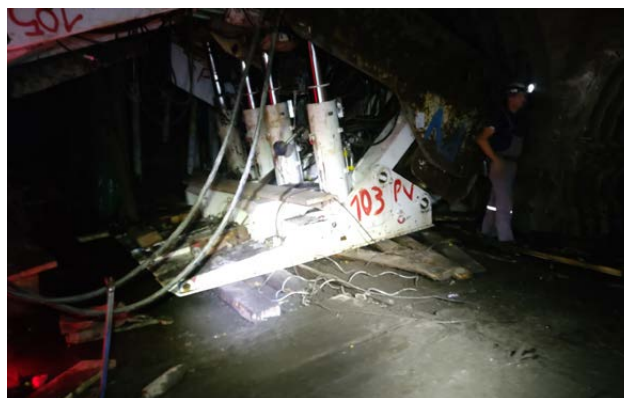
Vgradnja hidravličnega podporja na odkopu G5/B (foto: Klemen Mevc)
