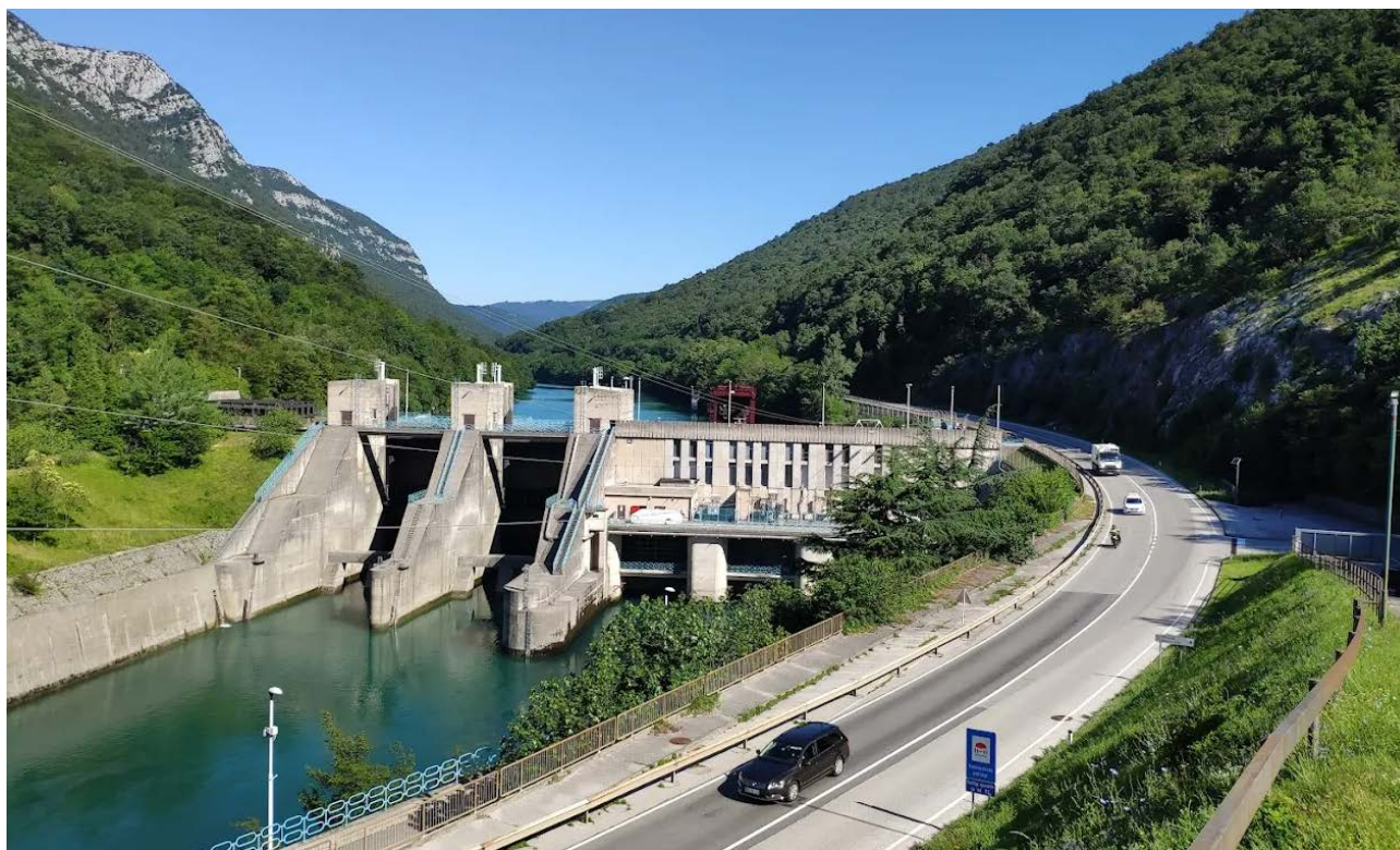
Hidroelektrarna Solkan (foto: Marko Ranzinger)
