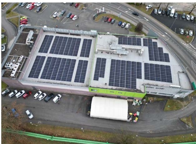
Pilon center Šošanj (240,240 kWp)
