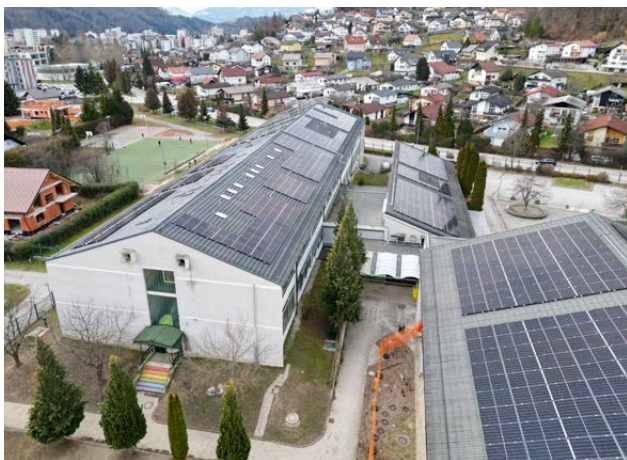
Osnovna šola Šalek Velenje (404,950 kWp)
