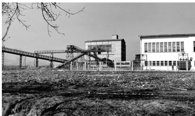
Transformatorska postaja na območju "starih" Prelog ...
