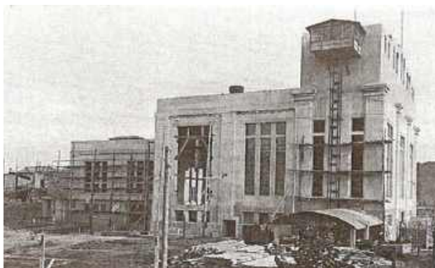
Elektrarna Velenje (Stara elektrarna) v času izgradnje leta 1925
