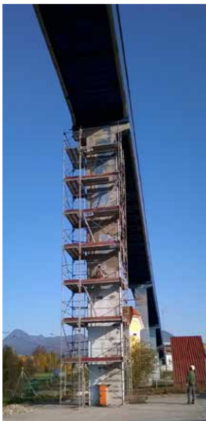
Sanacija je bila izvedena s pomočjo delovnih odrov in dvižnih košar.
