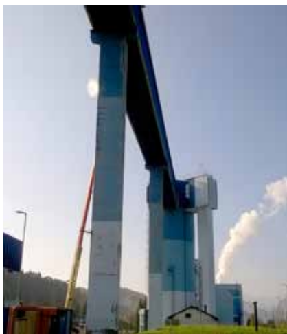
Pogled na najvišja stebra z vidnimi poškodbami konstrukcije in videz po sanaciji
