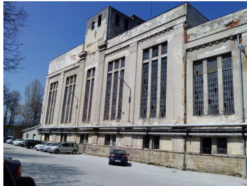
Slika 3: Pogled z vzhoda
